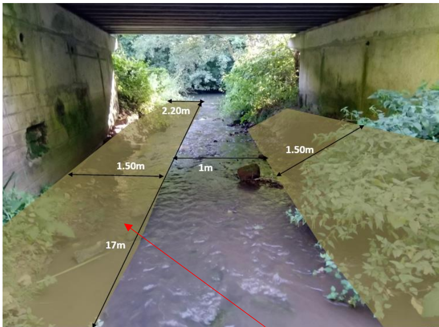
Aménagement sous le pont SNCF (remblais)
