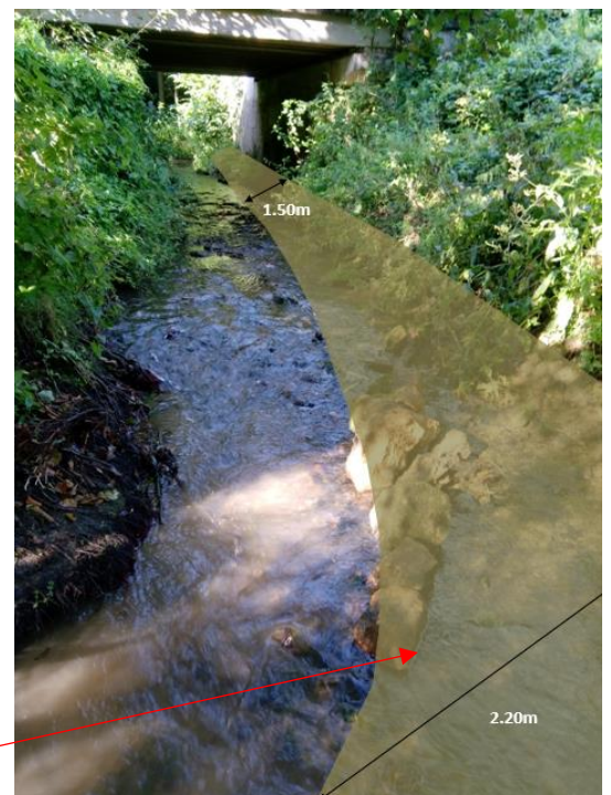
Aménagement confluence avec le Thérain (remblais)
