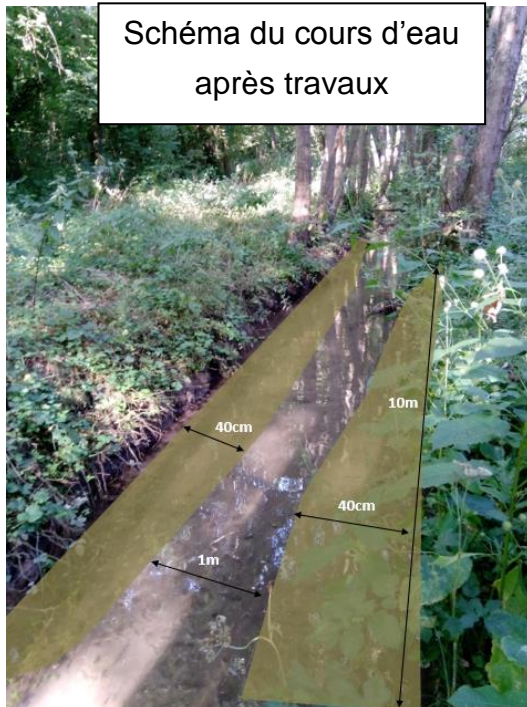
Réduction ligne d'eau avec banquettes de silex de chaque côté
